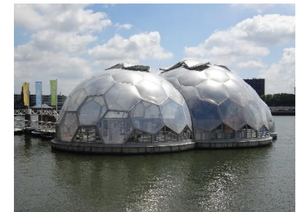
Abb. 3: Der schwimmende Pavillon ist ein Gebäude, welches auch bei steigendem Wasserspiegel auf der Wasseroberfläche schwimmt. Heizung und Klimaanlage werden mit Solarenergie betrieben und auch in der Stromversorgung ist der Pavillon fast autark. Er gilt als Pilotprojekt für klimawandelangepasstes Bauen, was in küstennahen Städten wie Rotterdam zunehmend an Bedeutung gewinnt.
